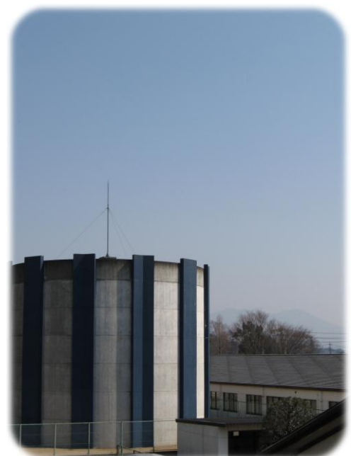
— 協和分区：協和浄水場配水池 —
