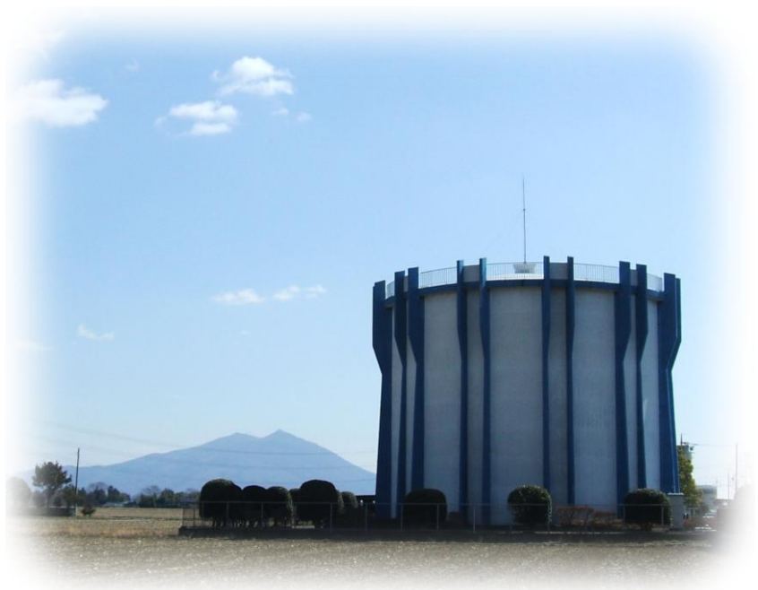
— 下館分区：成田浄水場配水池 —
